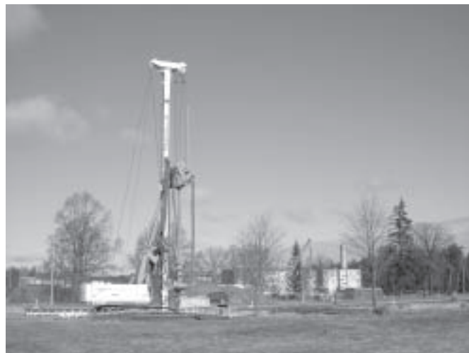
Dzelzceļnieku ciemata gājēju pārejas būve
